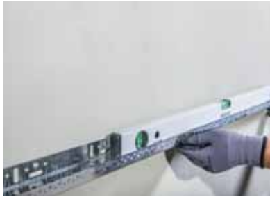
Слика 1 Празнини, вдлабнатини и испакнатини помеѓу ѕидот и Teknosistem цокле (Socle) профилот се корегираат со помош на тупли со различна дебелина, а површината се мери со васервага.
