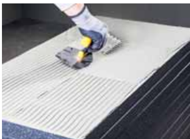
Слика 1 ако површината е рамна; адхезивниот малтер се нанесува на целата термоизолациона плоча со мистрија или соодветно засечена мистрија, користејќи го методот за лепење на целата површина.
