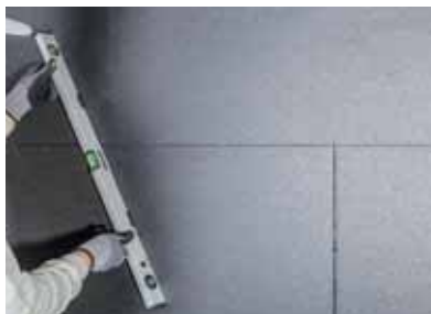
Слика 2 Нивоата на плочите треба да се проверат со васервага (либела),
