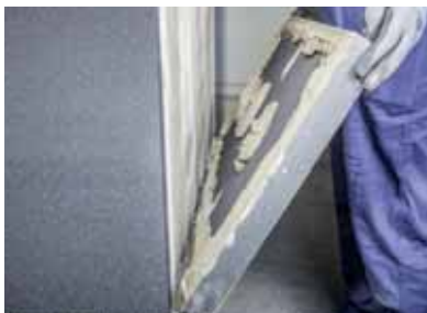
Слика 1 Термоизолационата плоча со адхезивен малтер што се нанесува на задниот дел треба да се постави на цокле (Socle) профилот без никакви празнини.
