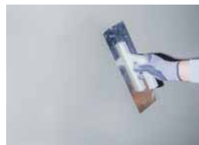
Слика 3 Нанесувањето на вториот слој од гипс малтерот е завршено по чекање за мала дехидрација на првиот слој во зависност од временските услови.
