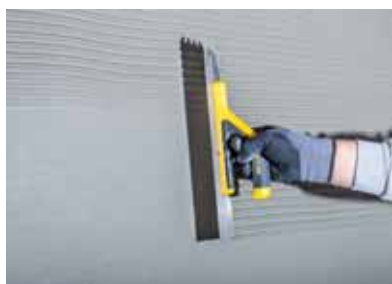
Слика 1 По лепење на Teknosistem термоизолационите плочи и поставување на сидни приклучоци, се нанесуваат два слоја површински малтер. Подготвениот Teknosistem гипс малтер се нанесува хомогено на површината со челична мистрија
