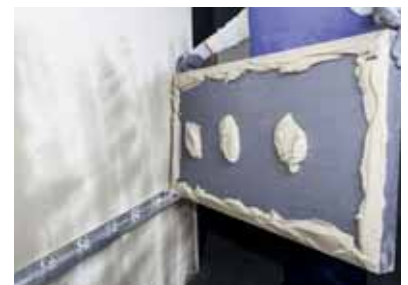
Слика 3 При нанесување на адхезивниот малтер на задната страна на изоационата плоча, се внимава да не се прелее на рабовите.
