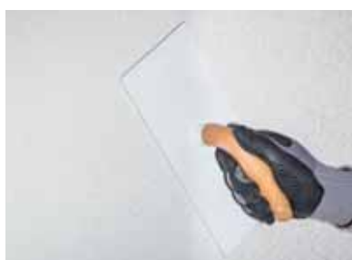
Слика 2 Со пластична мистрија се нанесува преку површината за да се формира текстура пред да се исуши.
