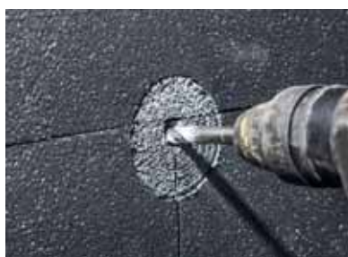
Слика 2 Локацијата на сидниот приклучок се дупчи. Големината на дупката треба да биде 1 cm поголема од големината на сидниот приклучок.
