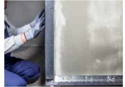
Слика 3 Димензиите на цокле (Socle) профилите, кои треба да се монтираат со растојание од 2-3 mm меѓу нив, се избираат врз основа на дебелината на термоизолационата плоча што ќе се користи.
