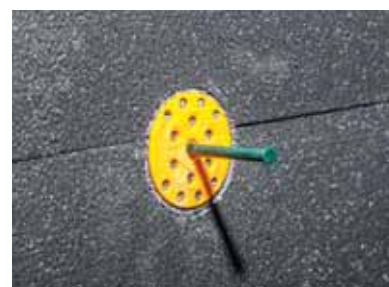
Слика 3 Во дупките се ставаат сидни приклучоци, типлите се забиваат целосно.
