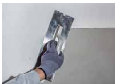
Слика 1 Teknosistem минерален декоративен малтер со текстура се нанесува на површината со мистрија.
