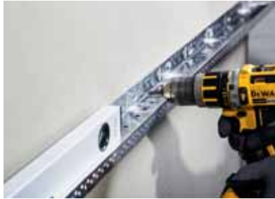
Слика 2 По процесот на израмнување, Teknosistem цокле (Socle) профилите се монтираат со помош на ѕидни приклучоци.
