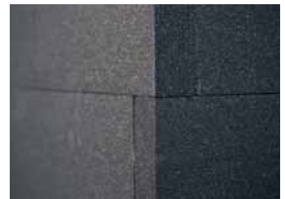
Слика 3 Термоизолационите плочи се поставуваат без празнини и во цик-цак стил почнувајќи од дното на ѕидот па нагоре. Плочите треба да бидат поставени во цик-цак стил и на аглите.
