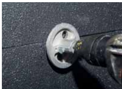
Слика 1 Потребно е вдување со употреба на апарати, за да се постави целосно главата на сидниот приклучок и да се спречи задебелувањето
